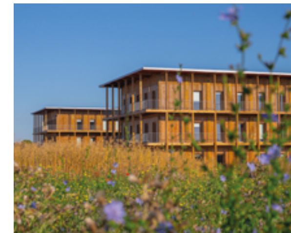
Le bâtiment Village.
